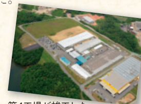
第4工場が竣工した三重ダイケン久居工場
