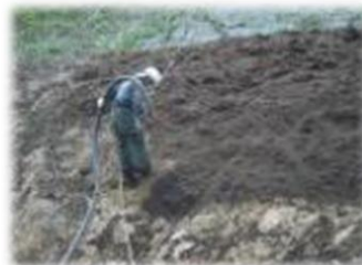
吹き付け緑化工
