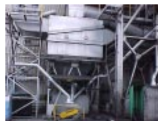
廃棄物ダイオキシン削減対策等のためにボイラー電気集塵機用の2次燃焼ダクトを設置
